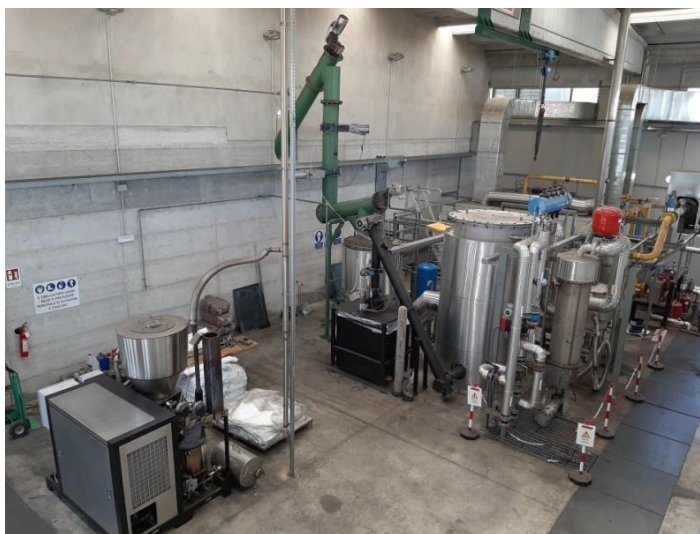
Figura 3: Impianto di gassificazione sperimentale da 25 kWe (in basso a sinistra) e linea produttiva impianto da 125 kWe
