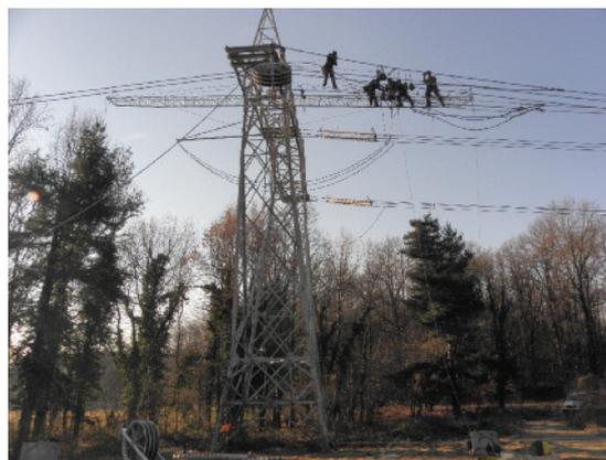
> Vista di una fase della prova di installazione in campo di conduttori innovativi.
