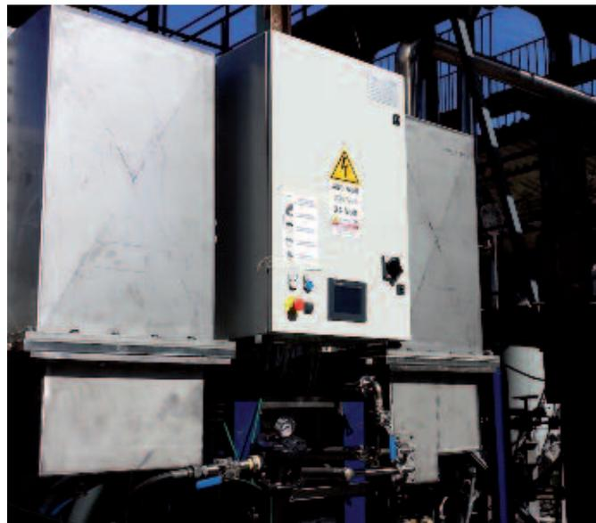
Il progetto riguarda la messa a punto di un processo di trattamento di pollina (letame di allevamenti avicoli), per risolvere il problema ambientale e trasformare un rifiuto in un bene, producendo energia elettrica e calore.
