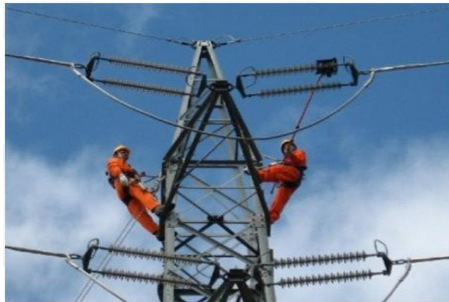
Misure di campo elettrico su isolatori compositi per la verifica di difetti. Terna - lavori sotto tensione
